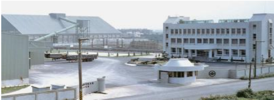
■ 海湖石膏板廠
