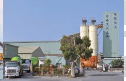
■ 台南預拌混凝土場
