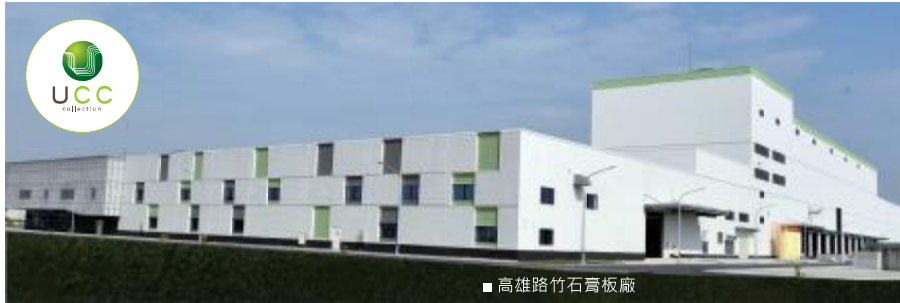
■高雄路竹石膏板廠
