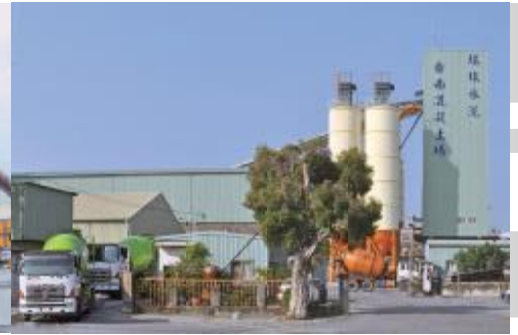
■ 台南預拌混凝土場
