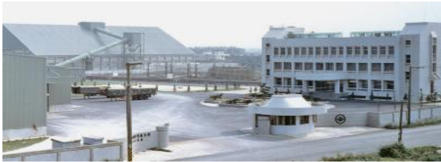
■ 海湖石膏板廠
