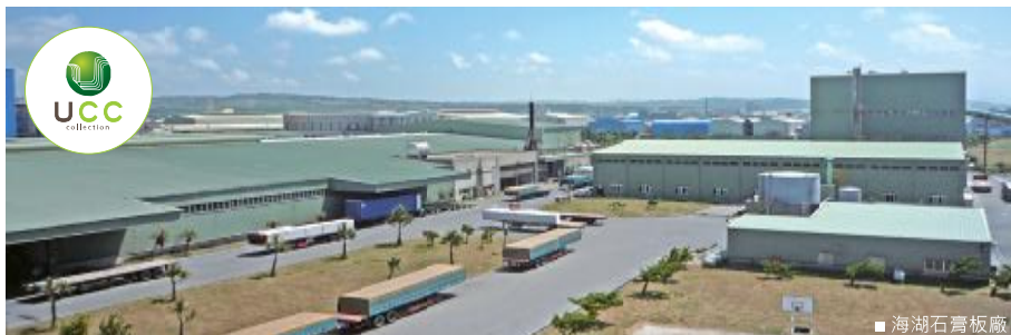
■ 海湖石膏板廠
